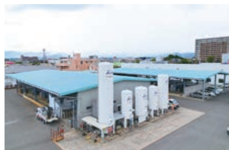
P.10 本社建屋前にある充填場。メーカーから原料ガスを受け入れ、貯蔵している
